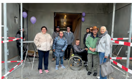
Rohbauhock im RIVA-Projekt im Färber-/Rhomburg-Areal – ab 2027 der neue Standort der Werkstätte Dornbirn Riedgasse.
