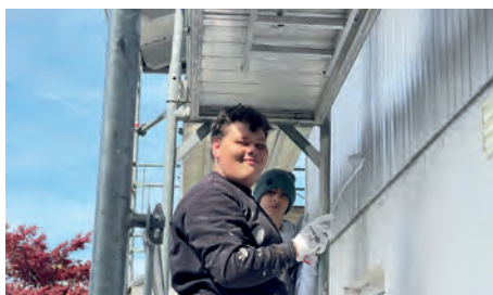
IAZ: Die praktische Ausbildung erfolgt im Berufsfeld Malerei auf privaten Baustellen.
