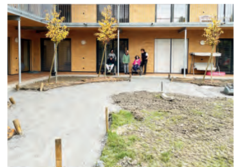
Im Herbst wurde mit dem Bau des barrierefreien „Sinnesgarten“ begonnen.
